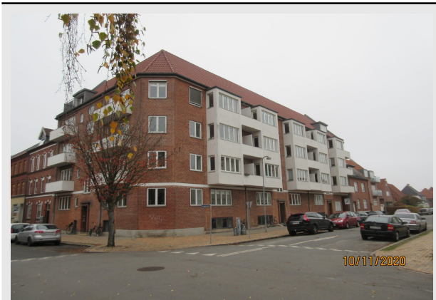
Tag, mod Henriettevej/Annasholmsgade.
